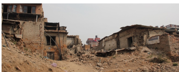
Noch überall zu sehen: Erdbeben-Ruinen
